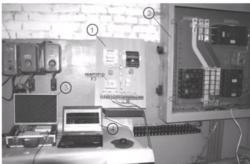
Рис. 6. Экспериментальный стенд для регистрации перенапряжений в действующей электрической сети при отключении КЗ:
